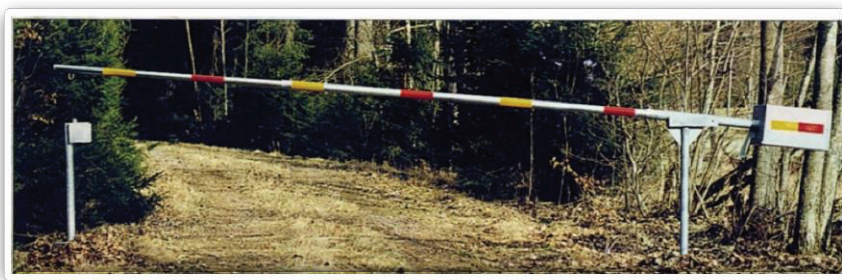
Lyftbom med motviktsbehållare fylld med grus till jämviktsläge.
